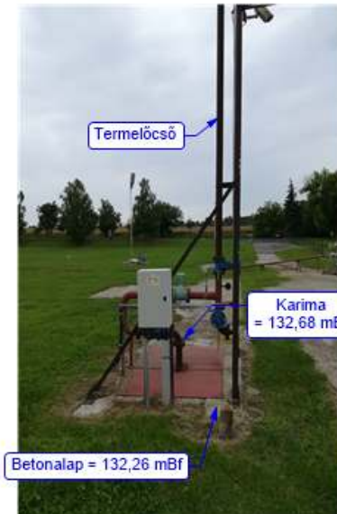
G ábrák: Termálkút 2018 évi bemért pontjai és eredeti műszaki rajzának másolata:
